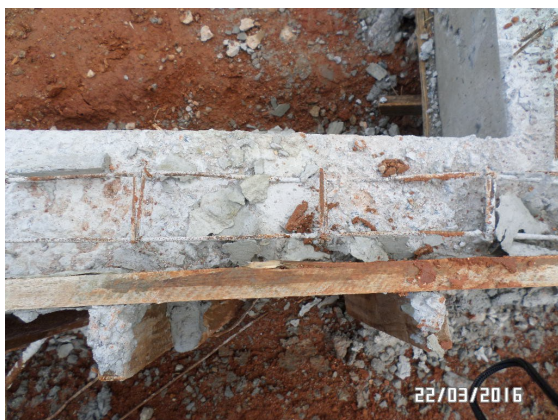
Falhas de cobrimento e más condições das ferragens
