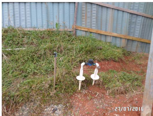
Cavalete instalado no canteiro
